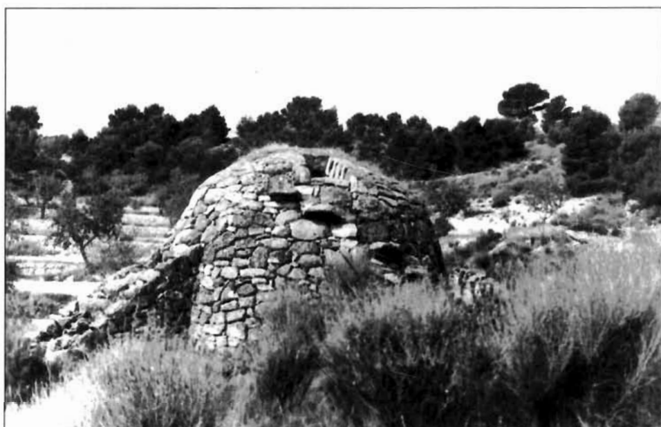
Lámina XII. Cuco de Zacarías, en La Alberquilla. Jumilla. Se puede observar el dispositivo de escalera en voladizo y la abertura superior para introducir la paja.
