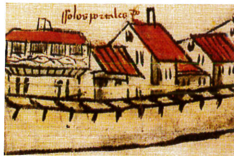
Fig. 16. Casas con chimeneas en la Plaza Nueva.
