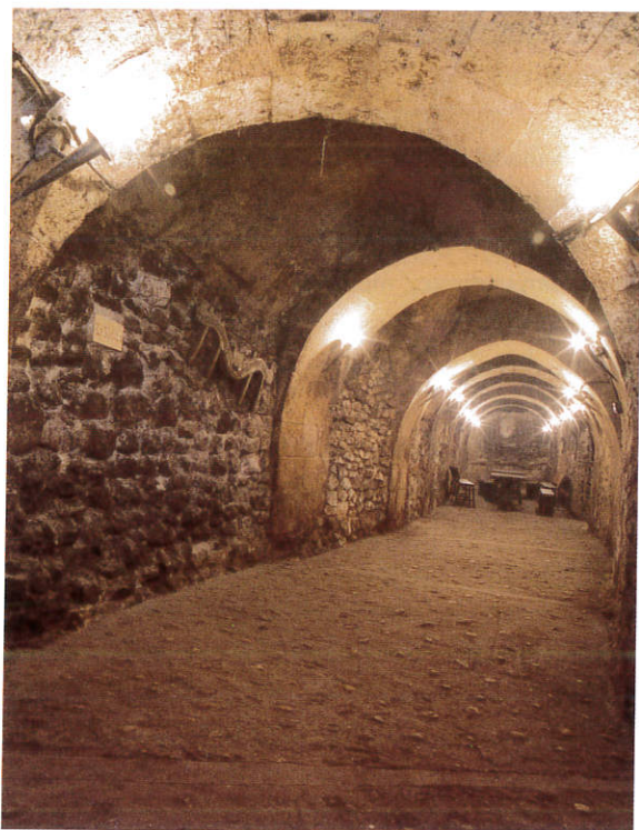
Nave de la bodega "La Navarra". Peña La Ribera. Foto F. Lara.
