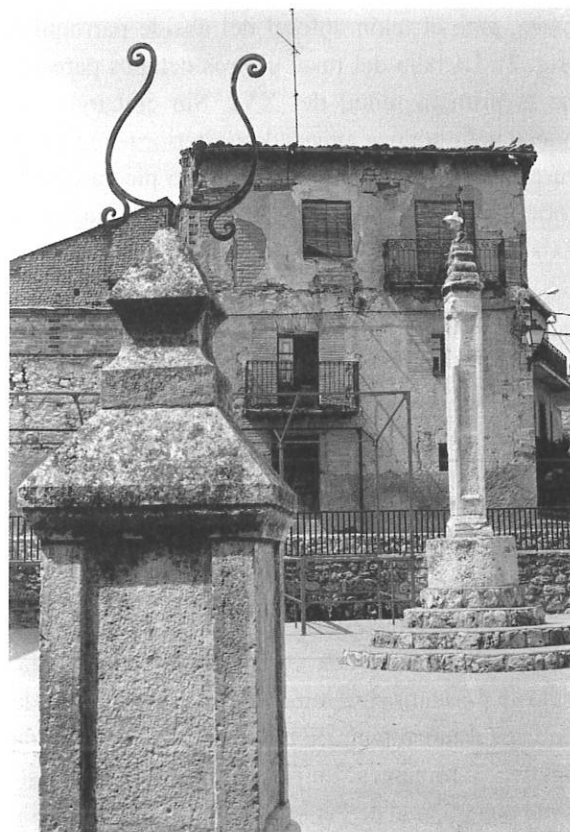
Figura 5.- Rollo de Zazuar visto desde el monolito de la fuente. El rollo ha sido montado sobre un cilindro que debió ser pesa de lagar para convertirlo en farola, a principios del siglo XX.
