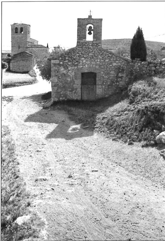
Figura 28.- El humilladero de las Angustias en Terradillos de Esgueva levanta su fachada frente a los caminantes que llegan al pueblo, orientación típica en las ermitas de la Ribera burgalesa.
