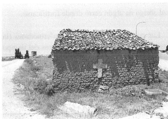
Figura 13.- Cruz empotrada en Gumiel de Mercado. Probablemente formó parte de un viacrucis desaparecido y ha sido reaprovechada en el muro.
