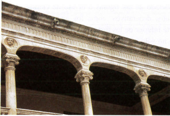
Patio. Piso superior.
