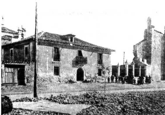
Colegio de la Vera Cruz y ruinas del convento de San Francisco
