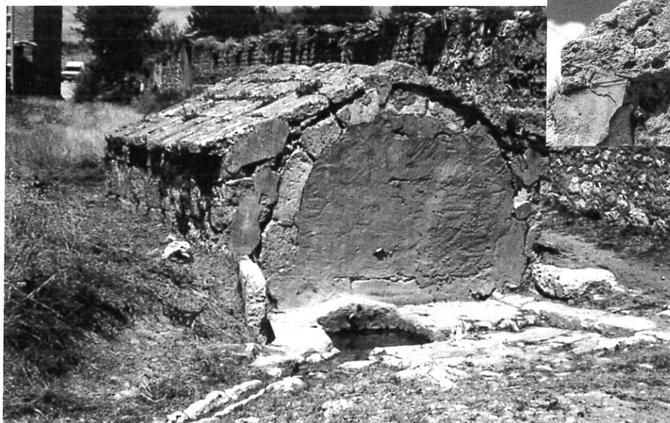
Detalle e imagen actual de la fuente de Santa María. Por la información que recoge con Justo Revuelta en su Memoria , a finales del siglo XIX ya estaba cerrada. Por ello, sus aguas eran de mejor calidad que las de la fuente de San Pedro, pero parece que era menos concurrida que ésta al estar algo más alejada del pueblo. (Fig. 3 a-b).
