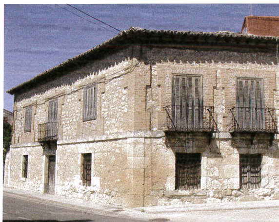
Casa, fábrica mixta de piedra y ladrillo con influencias neoclásicas. Gumiel del Mercado
