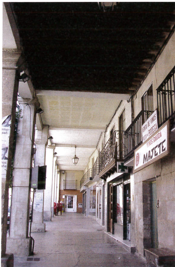
Interior del pórtico de la Plaza Mayor, Roa de Duero.
