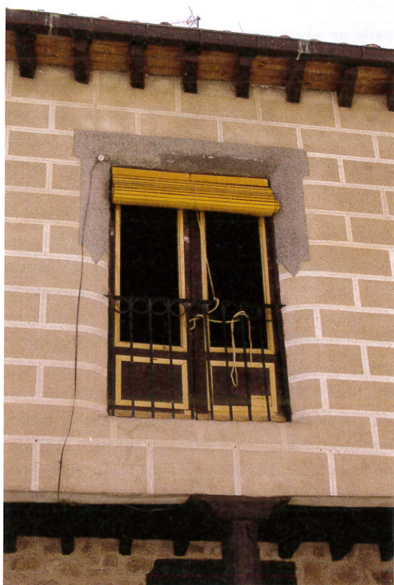
Revoco raspado en despieces de sillares. Casa de Sto. Domingo de Guzmán. Gumiel de Hizán.
