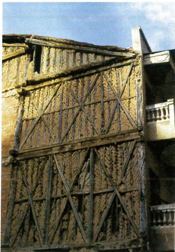
Entramado de madera en medianera. Aranda de Duero.
