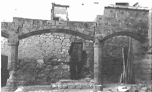
Un aspecto de una de las galerías del Patio de Armas durante su restauración en los años 60.
