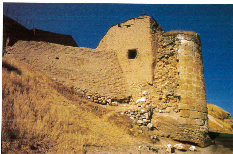
Murallas de Roa, en construcción en 1295 y objeto entonces de un litigio entre la villa y sus aldeas.
