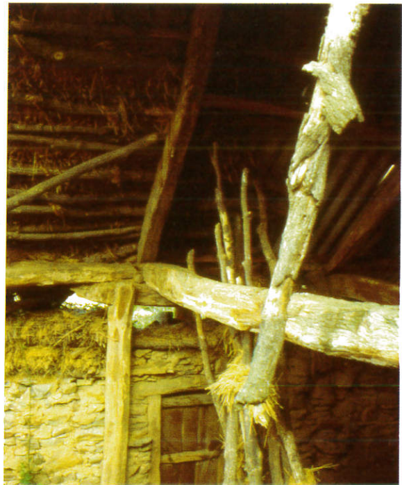
Horcón de apoyo y semicercha de cubierta de teito. Villar del Monte (León).
