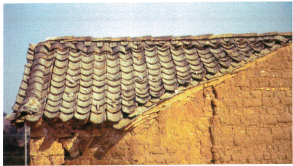
Tejado a canal. Fuentenebro (Burgos).
