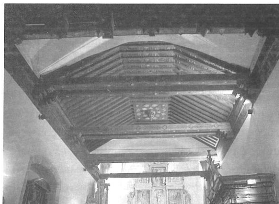
Vista general de la nave y techumbre.
