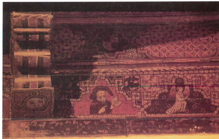
Detalle del Almizate, sección 1 muro norte. San Benito, santa Escolástica y Santiago Matamoros.
