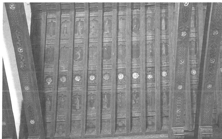
Vista general del faldón norte.
