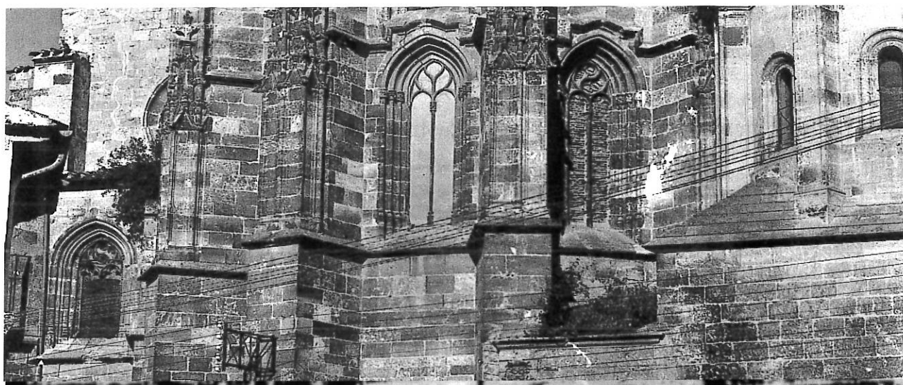
IGLESIA DE STA. MARIA. VISTA PARCIAL ARCH. FOT. BIBLIOTECA MUNICIPAL
