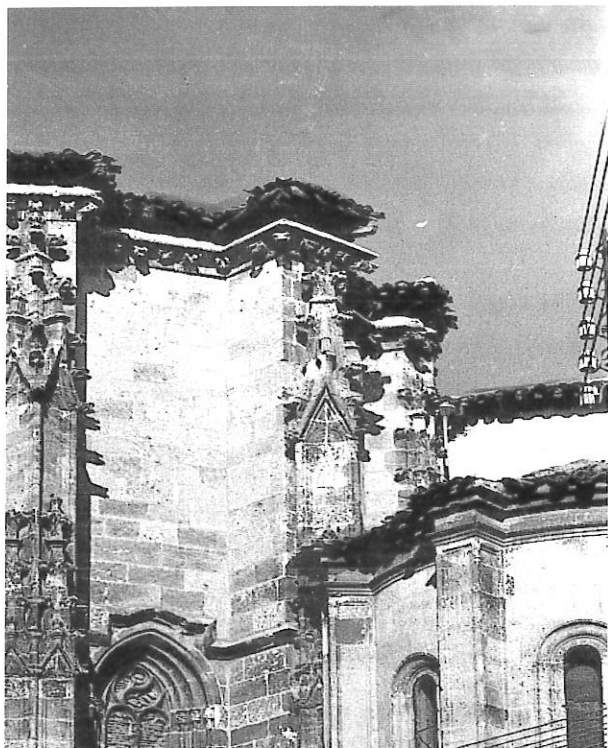
IGLESIA DE STA. MARIA. VISTA PARCIAL. ARCH. FOT. BIBLIOTECA MUNICIPAL
