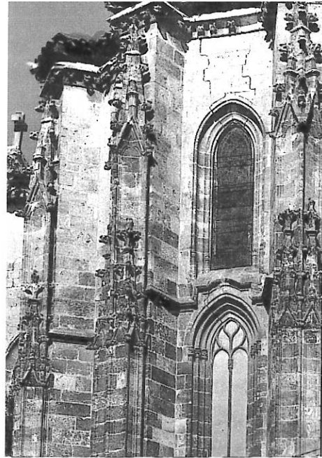
IGLESIA DE STA. MARIA. VISTA PARCIAL ARCH. FOT. BIBLIOTECA MUNICIPAL
