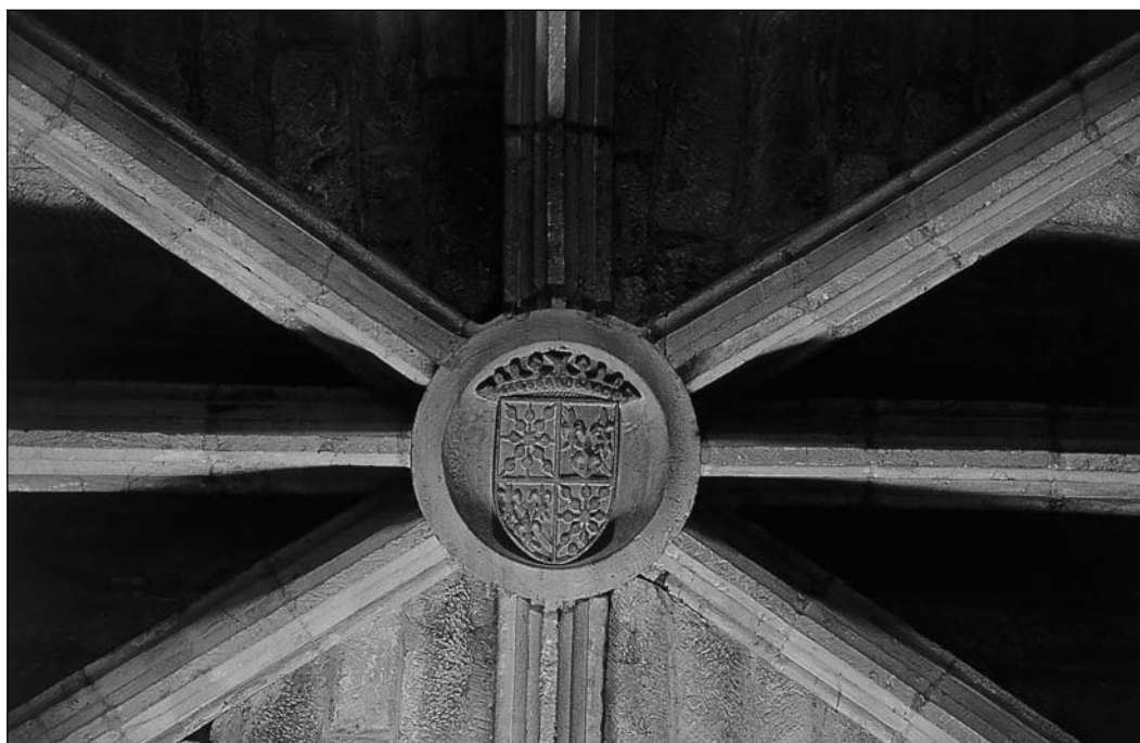
Leire. Clave del primer tramo de bóveda
