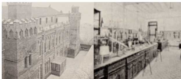
Figura 4. Vista lateral del IQS y de uno de sus laboratorios.
