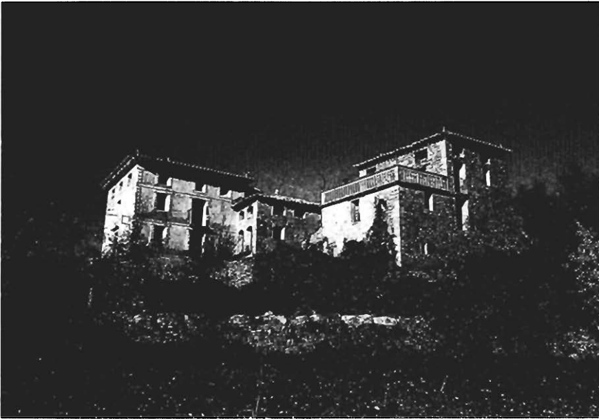
Vista de la casa conocida como El Albañil de Caballera. Foto: J. L. Acín.
