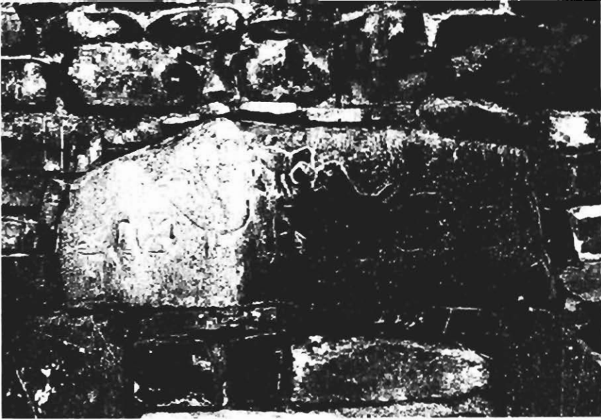
Cabecero de la ventana de Casa O Royo de Yosa de Sobremonte. Foto: J. L. Acín.
