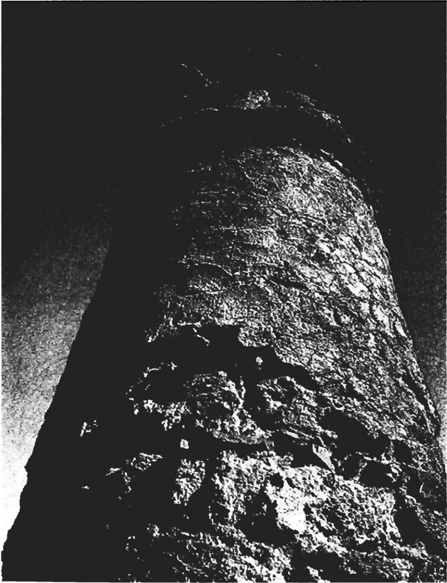
Chimenea de Casa Lacasa de Escartín. Foto: J. L. Acín.
