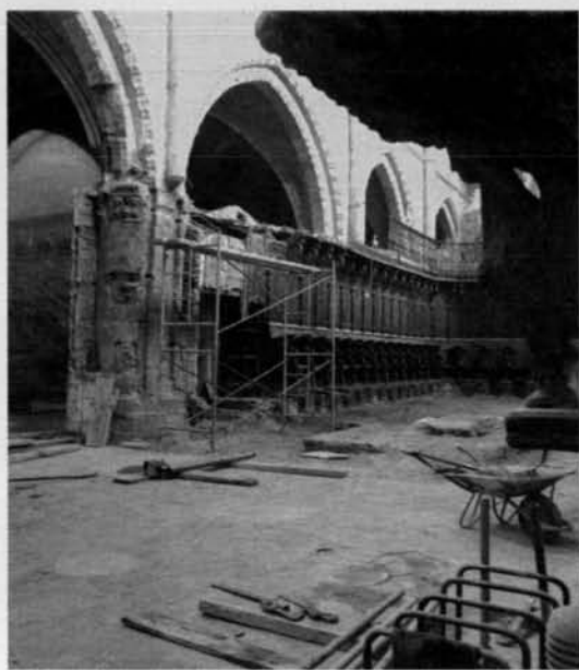
Proceso de desmantelamiento del coro en 1985.
