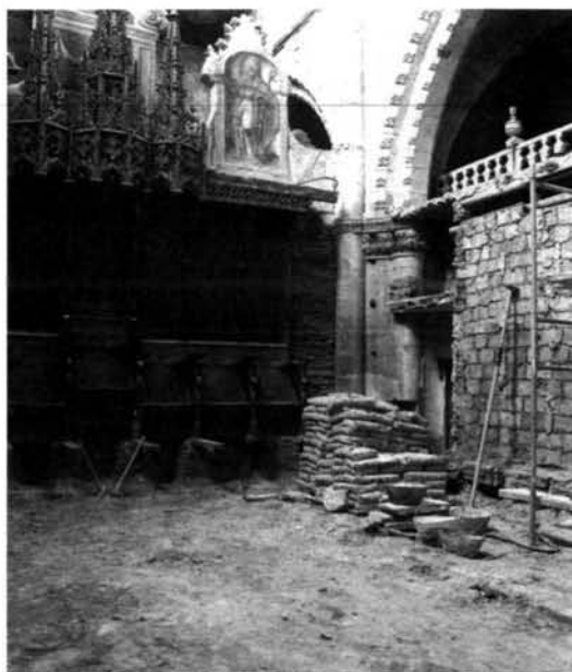
Proceso de desmantelamiento del coro en 1985. Foto Archivo C.E.T.
