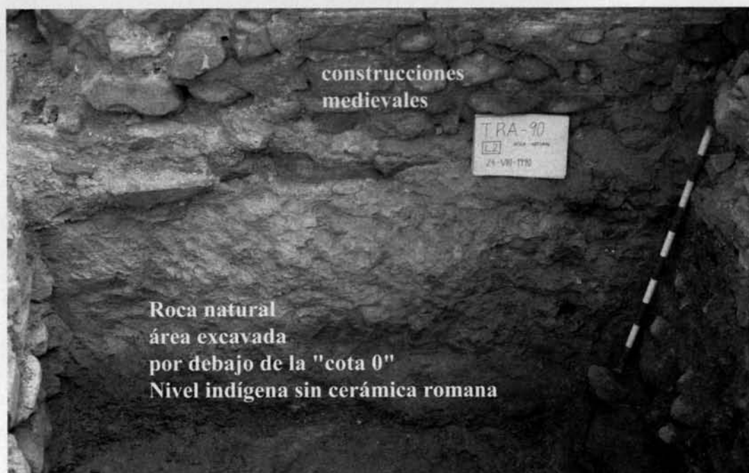
2. Rúa Alta: Zona rebajada en la roca natural por debajo de la "cota 0" en el que se ha preservado el nivel indígena. El muro de piedra que se apoya en la roca corresponde a las edificaciones medievales.
