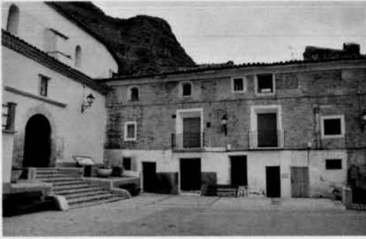
13. Fachada principal del palacio de los duques de Villahermosa y lateral de la iglesia parroquial de Los Fayos. Foto: Juan C. Lozano.
