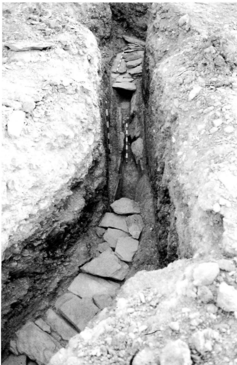
LÁM. 5. Atarjea de evacuación de aguas.
