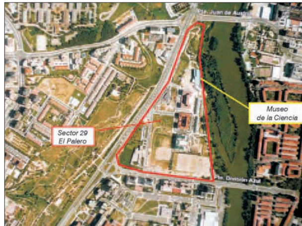
FIG. 3. Primera fase de las obras de construcción del Museo de la Ciencia.
