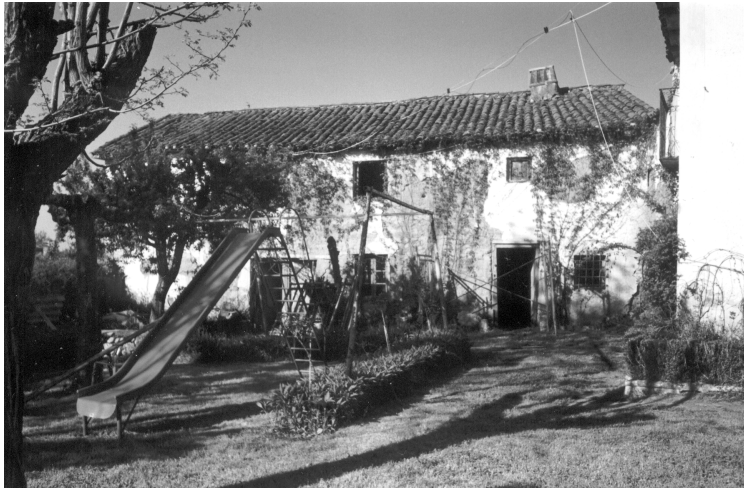
Garrafe de Torío, junio 1998. El edificio estaba revocado de cal y se le aplicó un embarrado de la fachada exterior, eliminando un tabique entre puerta y ventana. Al nuevo hueco se le colocaron un cargadero y un pilar central, ambos de roble. Se mantuvieron las puertas y ventanas originales, de madera.
