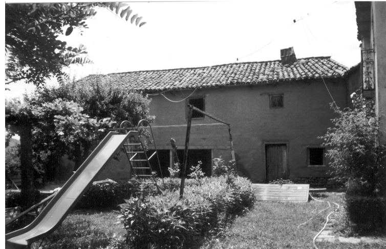
Garrafe de Torío, junio 1998. El edificio estaba revocado de cal y se le aplicó un embarrado de la fachada exterior, eliminando un tabique entre puerta y ventana. Al nuevo hueco se le colocaron un cargadero y un pilar central, ambos de roble. Se mantuvieron las puertas y ventanas originales, de madera.
