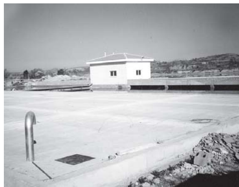
Planta Potabilitzadora construïda el 2000, al terme de Bellmunt d'Urgell, on hi ha els dipòsits d'aigua potable de Linyola. Fotografia: J.Civit.
