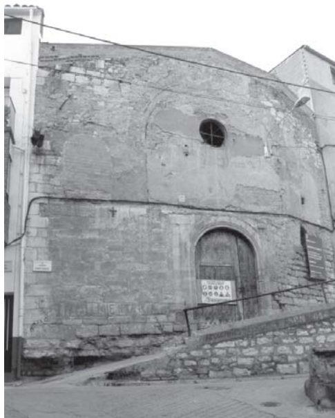
Fig. 2 Façana de l'església de Sant Gaietà d'Aitona.
