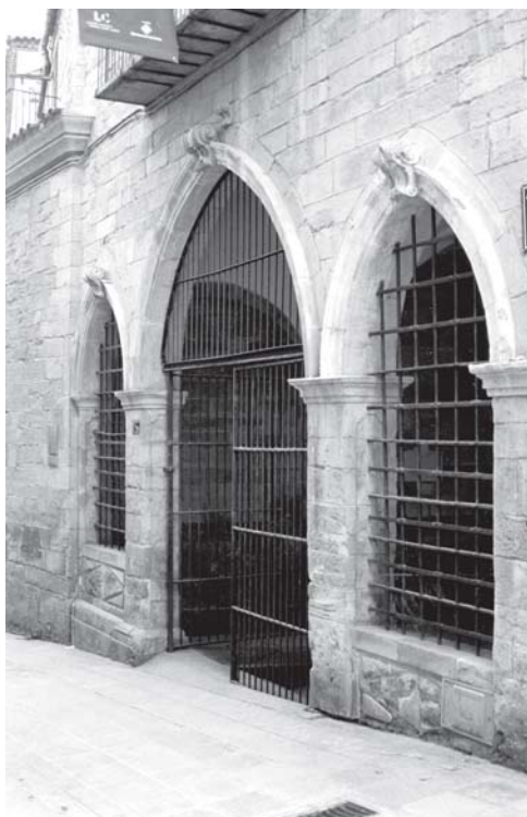
Fig. 5. Pòrtic del convent Dominic, al carrer dels Cavallers. Els tres arcs són apuntats i construïts cap el 1742.
