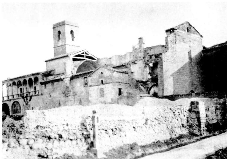
Fig. 3 Vista sud-est de l'església en estat ruïnós abans del 1897, convent de Sant Bartomeu, Bellpuig.
