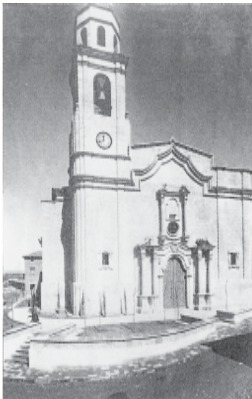
(Fig. 17) Vista general de l'església, tot just acabades les obres de reconstrucció. AHL, Fons "Regiones Devastadas" i a "Monografies d'Arquitectes Lleidatans. F. Clavera A.", pàgs. 62-63.
