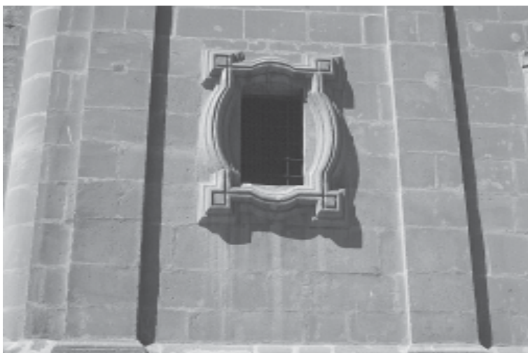
(Fig. 26) Façana principal: finestra lateral. Fotografia de l'autor.
