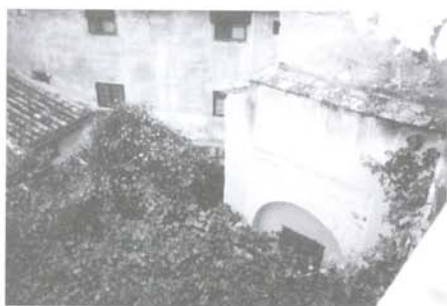
Fig. 9. Uno de los tramos de la iglesia de San Ginés y el pequeño patio.
