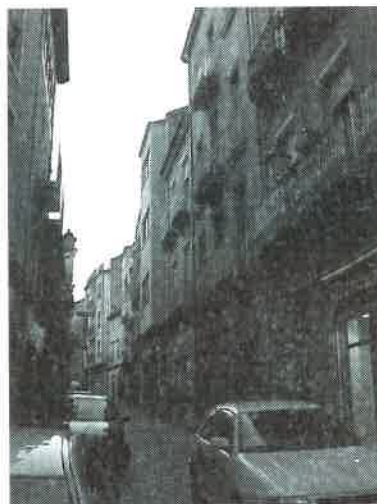
Lámina 3.- Estado actual de la Calle Villar.
