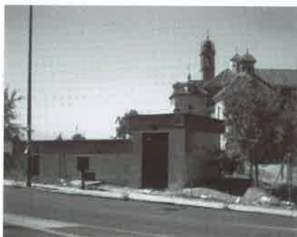
Fig. nº. 13. Caseta de instalaciones eléctricas sita en la manzana del Monasterio
