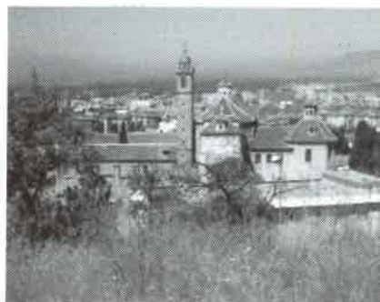
Fig. nº. 16. Vista general del monasterio y su entorno desde la Facultad de Filosofía y Letras. Edificio A
