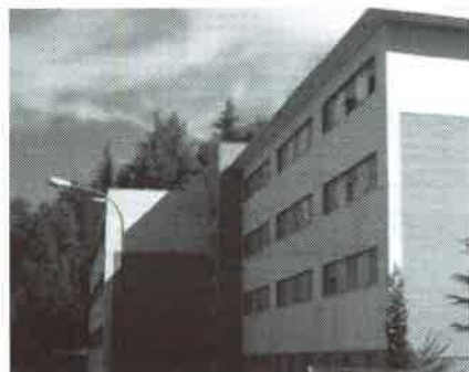
Fig. n.º 11. Vista de las Residencias Universitarias de la zona 4.
