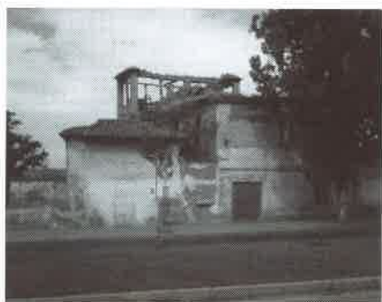
Fig. nº. 5. Restos del Cercado Bajo y edificio en Ruinas. Paseo de la Cartuja
