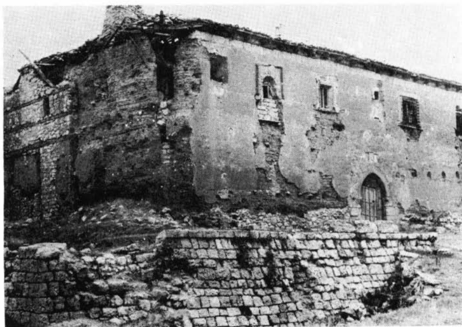
Lámína II — CASTRILLO DE DON JUAN. Palacio-fortaleza de los Delgadillo. 1. Vista general desde el Sureste. 2. Vista general desde el Suroeste.
