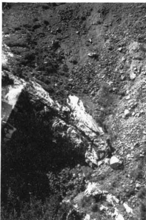
Vaguada de arrastre en la boca de la Sima del Anillo. Asegurando para la colocación de SPITS para el anclaje de la Tirolina.
