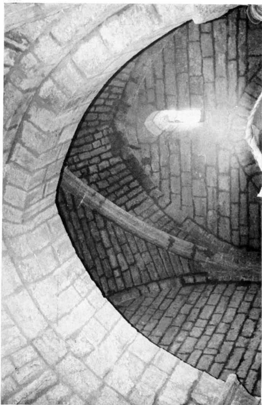
Lámina 8.—Arco toral que divide al edificio en dos partes asimétricas.
