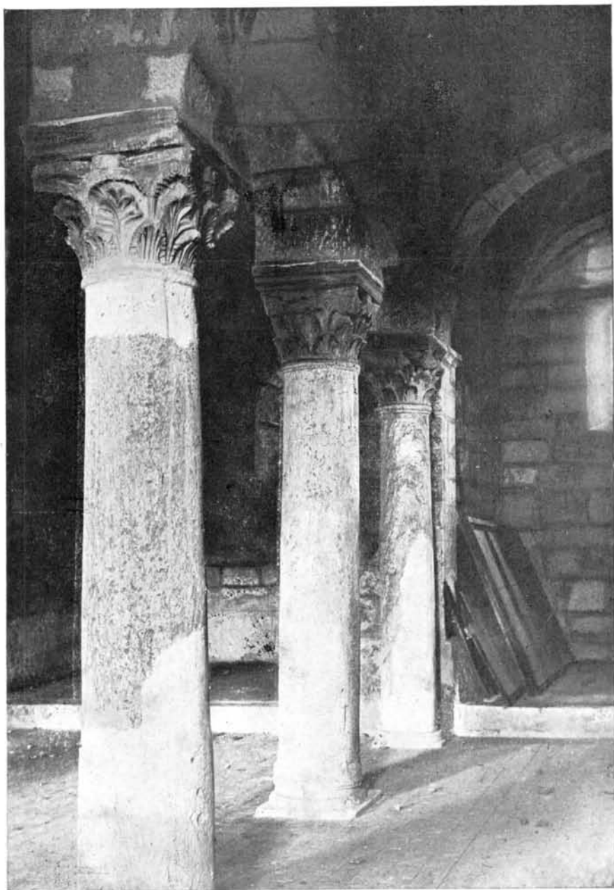
Interior de la basilica de San Juan de Baños (s. VII).
