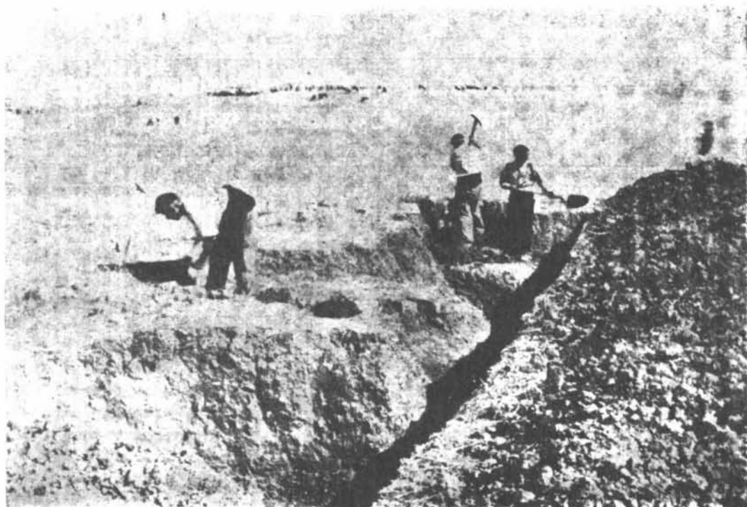
Los primeros trabajos de exploración en la tierra de «Los Silos».
