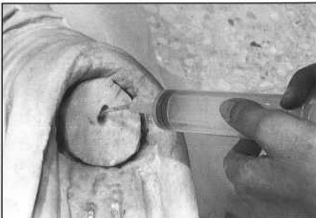
Lámina 17. Inyección de resina epoxídica.
