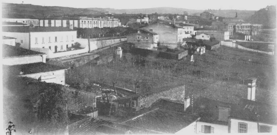
Fig. 12.- D. Francisco Javier Martínez Santiso tomou esta fotografía desde a súa casa da Rúa Nova, probablemente no 1911 cando non faltaba moito para que se inaugurasen (10-XI-1912) as escolas e o asilo dos Irmáns García Naveira, que se ve ó fondo rodeado de estadas. No centro vemos a "Feira Nova" (hoxe desaparecida) con plátanos recién plantados, dos que aínda sobreviven algúns. Xentileza de D. Luis Veiga.
