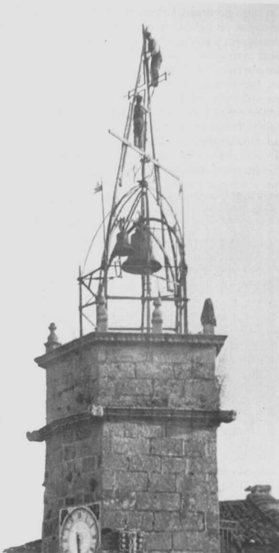
[Obreros trabajando en la Torre del Reloj. Fotografía de finales del s. XIX tomada por Francisco Javier Martínez Santiso. Fue donada al AMB por D. Luis Veiga].
