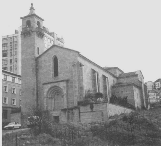
Ilustración X: Aspecto de la fachada occidental de San Francisco de La Coruña (Foto autora).
