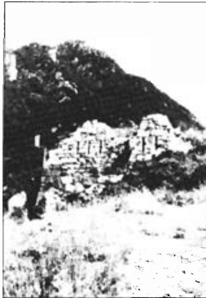
Fig. 6. La torre en su estado actual. Vista desde el noreste.
