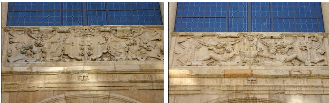
■ Lám. 5 a y b. Detalles de los antepechos del patio del palacio.
