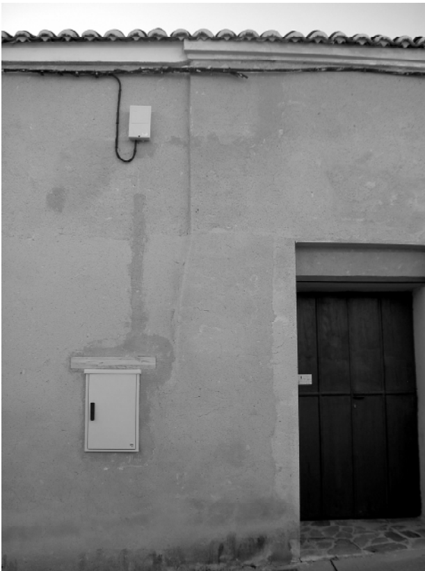
Detalle de construcción de La Comunal
