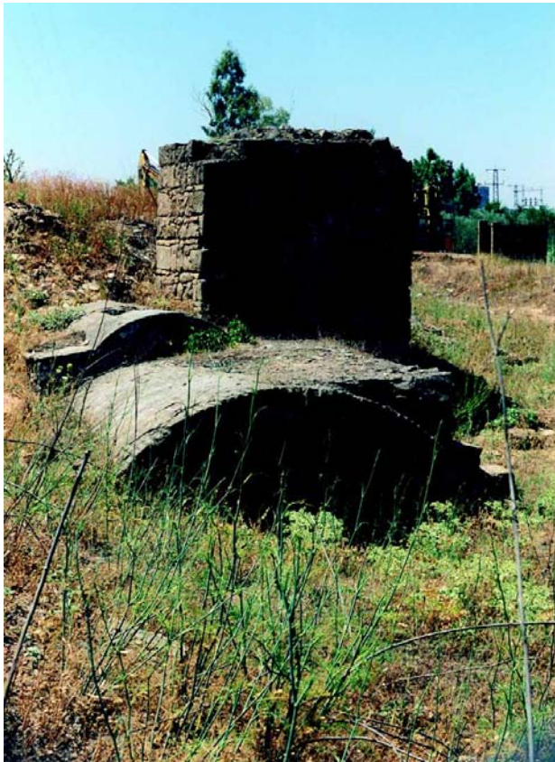
Restos de antiguas conducciones de agua en las proximidades del Santuario.
