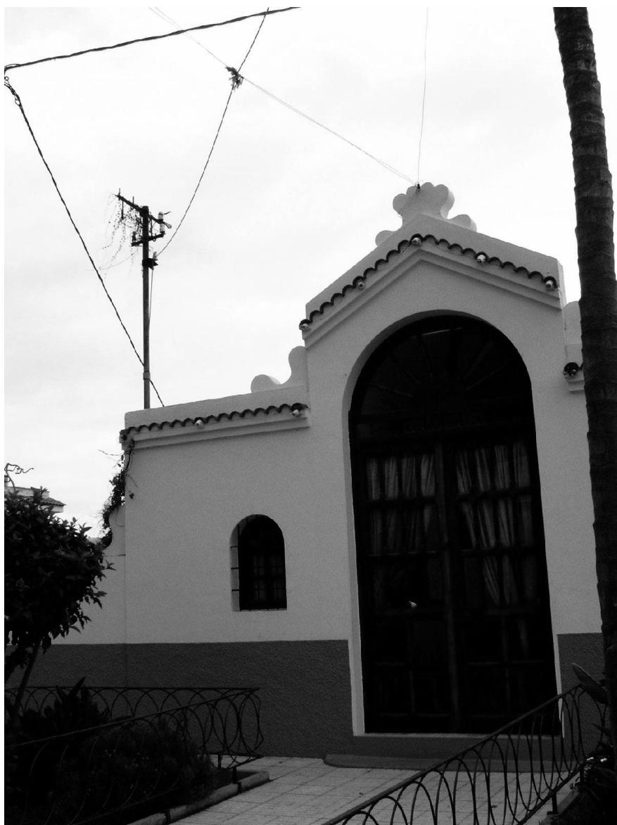
Fotografía 1: El Calvario, en la calle Real (La Matanza de Acentejo) (Autor de la fotografía: Francisco Javier León Álvarez)
