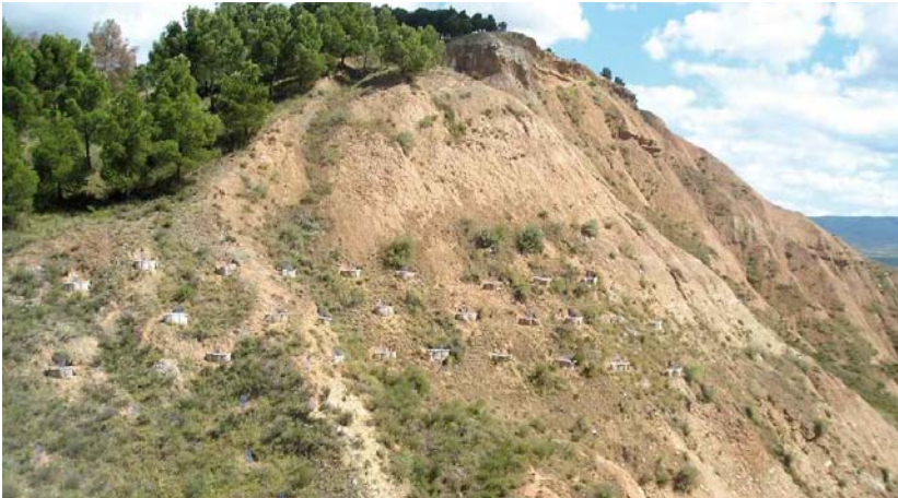
Empalizadas realizadas en fuertes pendientes (Autol).
