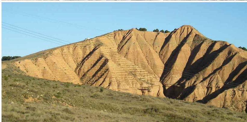
También se pueden usar tabloncillos de madera como estructuras de retención (Aldeanueva).
