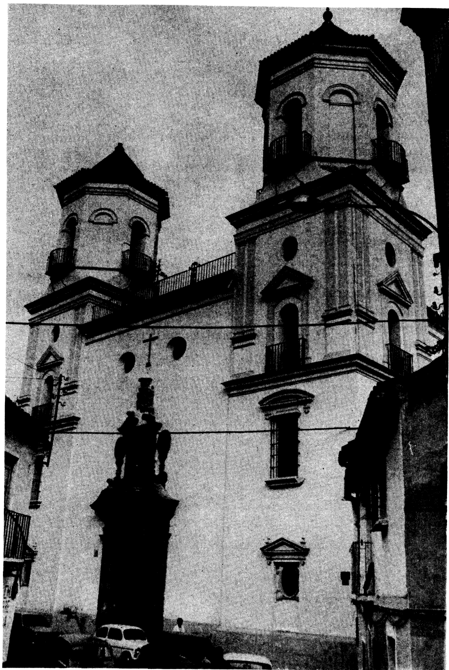
Fig. 14.—Fachada principal de la iglesia de San Felipe Neri.
