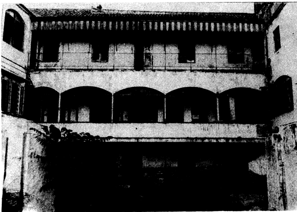
Fig. 8.—Perspectiva actual del patio principal de la Casa de Expositos.
