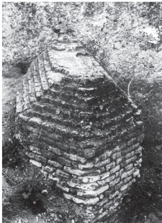
Fig. 4. Puente del Churre. Tajamar.
