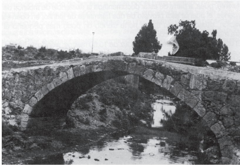
Fig. 1. Puente del Churre.
