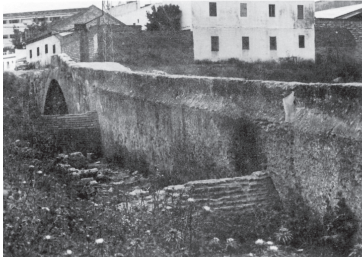
Fig. 3. Puente del Churre.
