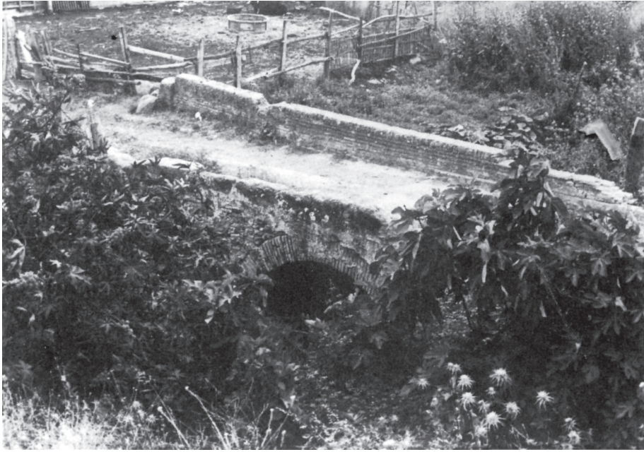
Fig. 5. Puente del Parrado.
