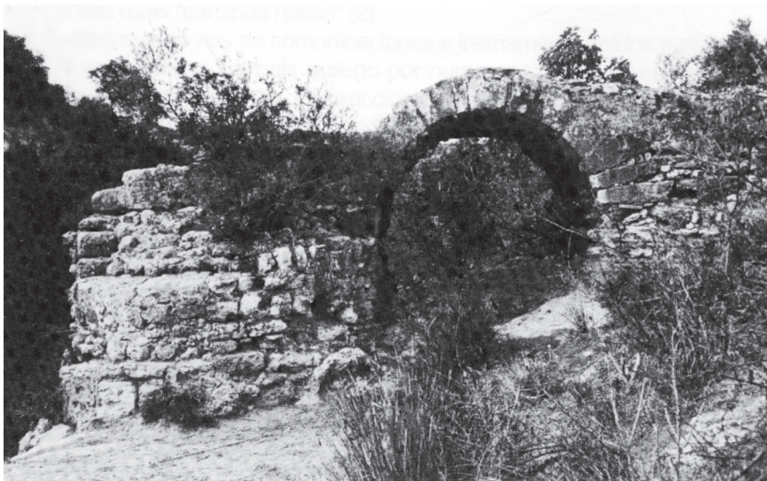
Fig. 8. Puente del Guadalvacar. Ojo lateral.
