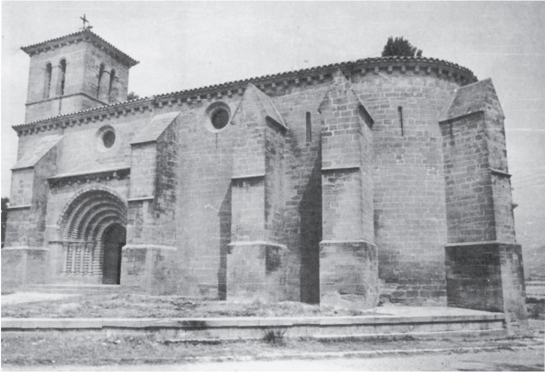
Fig. 5a: APIÉS (HU). Iglesia de San Félix remodelada tras la restauración.
