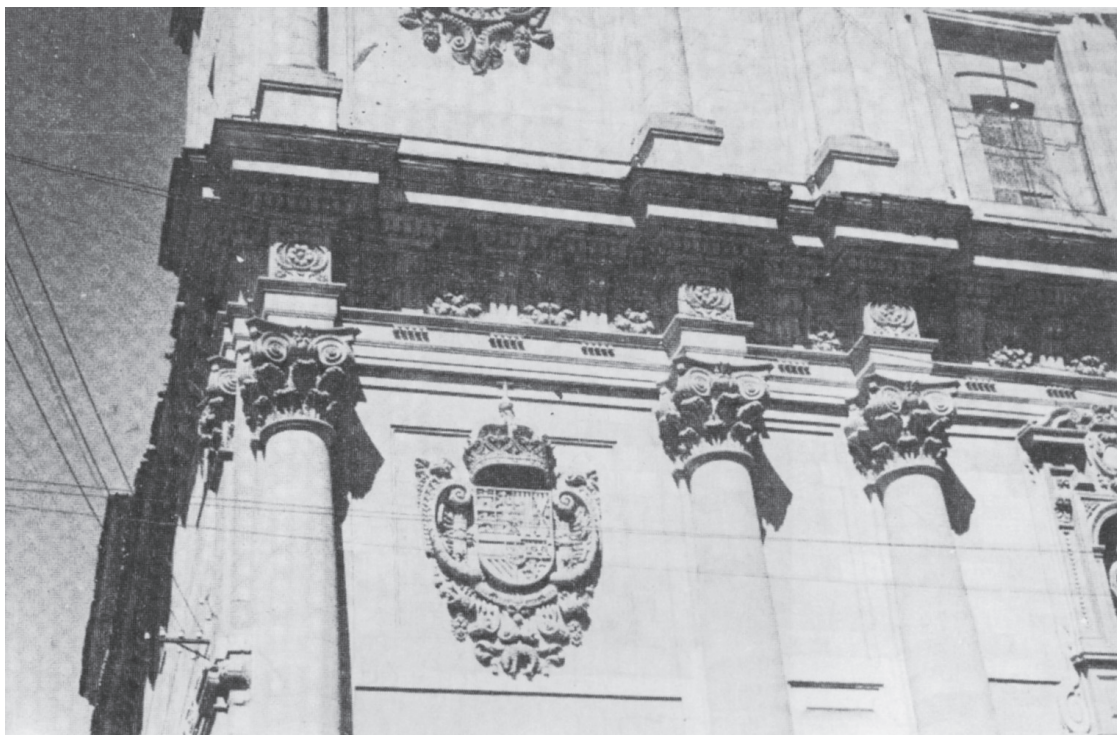
Lám. 1: Detalle de la fachada de la iglesia del Colegio Real (Clerecía). Salamanca.
