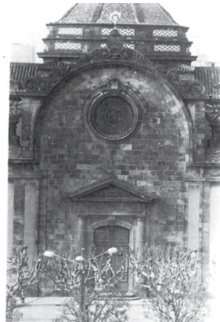
Fig. 6: Iglesia de la Ciudadela de Barcelona . Estado actual de la fachada.
