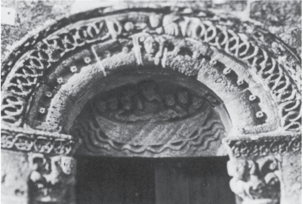
Fig. 1. Iglesia de Santiago de Cereixo. Coruña. Puerta Sur.
